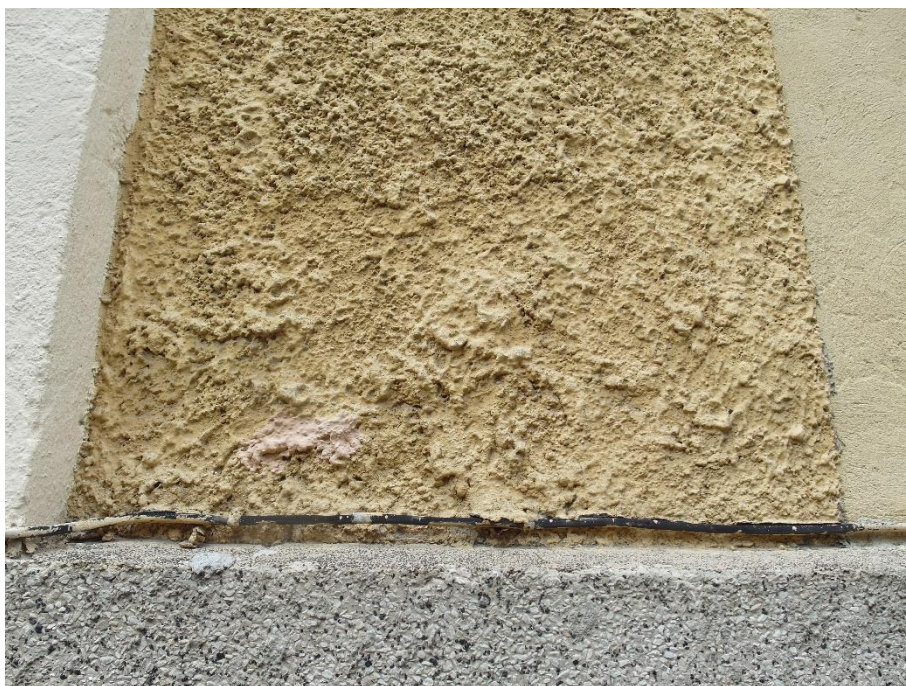
Sopot, ul. 1 Maja 12, Dom Studencki nr 8. Wtórne wyprawy tynkarskie wypłukane i spłowiałe; widoczne spękania i przeprowadzone po licu instalacje elektryczne.
