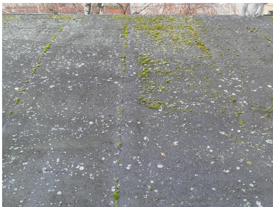
Sopot, ul. 1 Maja 12, Dom Studencki nr 8, elewacja północna. Taras nad III kondygnacją pokryty warstwą papy termozgrzewalnej, na której bytują liczne mchy i porosty; wyprawy tynkarskie komina wentylacyjnego zabrudzone i zawilgocone.
