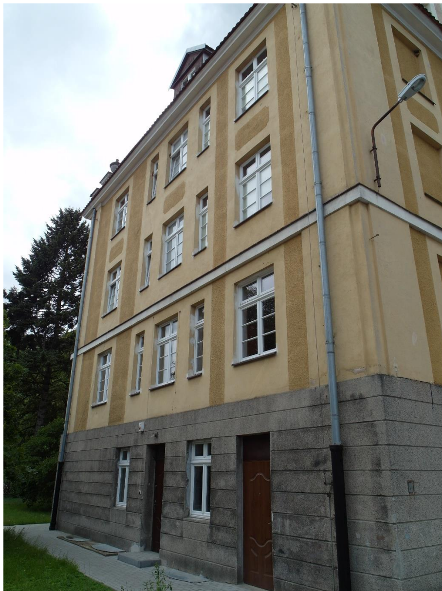
Sopot, ul. 1 Maja 12, Dom Studencki nr 8, elewacja wschodnia. Tynkowane lico części południowej pokryte zabrudzeniami i zanieczyszczeniami, szczególnie w dolnej kondygnacji; w partiach pod oknami parteru i nad poziomem gruntu widoczne naprawy warstw tynkarskich.
