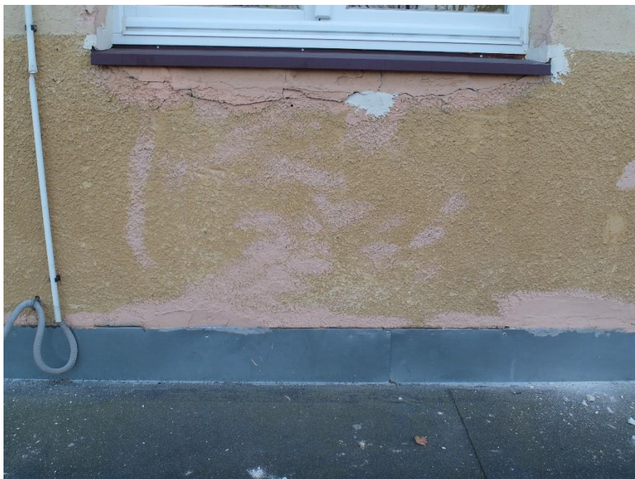
Sopot, ul. 1 Maja 12, Dom Studencki nr 8, elewacja zachodnia i północna. Tynkowane lico nad posadzką tarasów silnie zawilgocone, zasolone z ubytkami w warstwie tynkarskiej.
