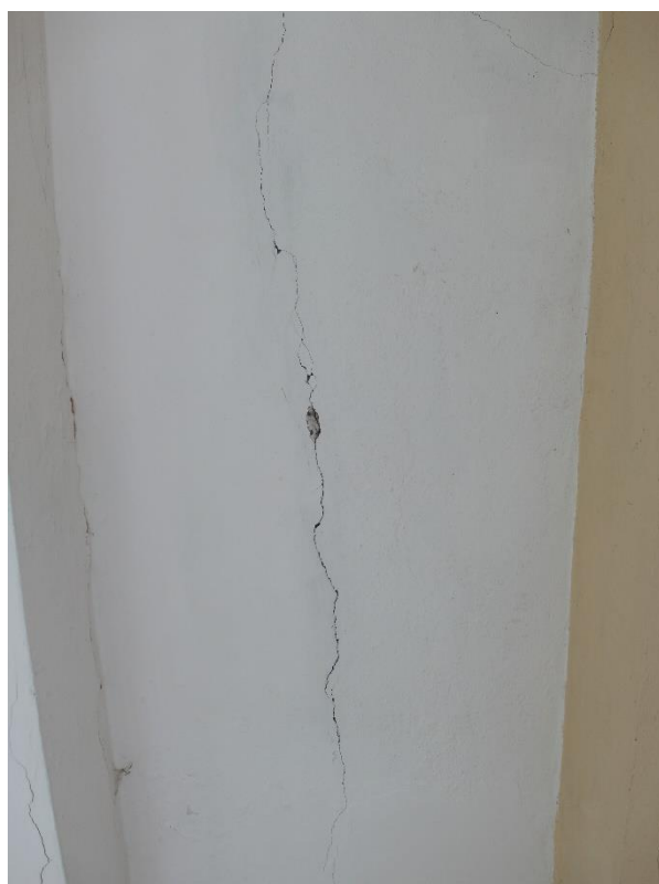
Sopot, ul. 1 Maja 12, Dom Studencki nr 8, elewacja południowa. Taras II kondygnacji, widoczne silne zabrudzenia tynkowanego lica; struktura belkowania spękana konstrukcyjnie.
