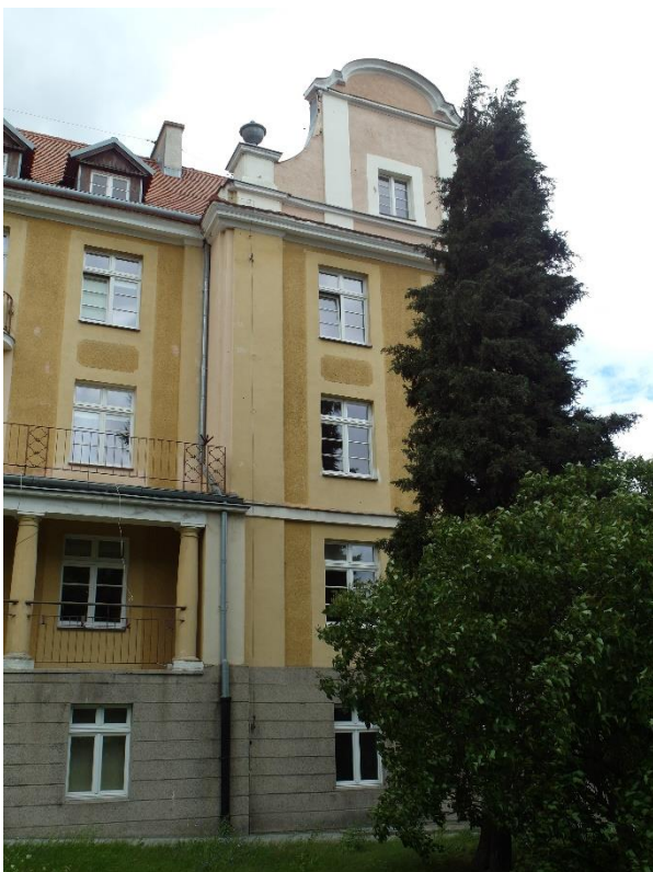
Sopot, ul. 1 Maja 12, Dom Studencki nr 8, elewacja południowa. Tynkowane lico elewacji pokryte zabrudzeniami i zanieczyszczeniami, miejscami silnie wypłukane; widoczne partie o zmienionej kolorystyce – efekt współczesnych napraw [szczyty, pilastry przy dolnym tarasie kolumnowym].
