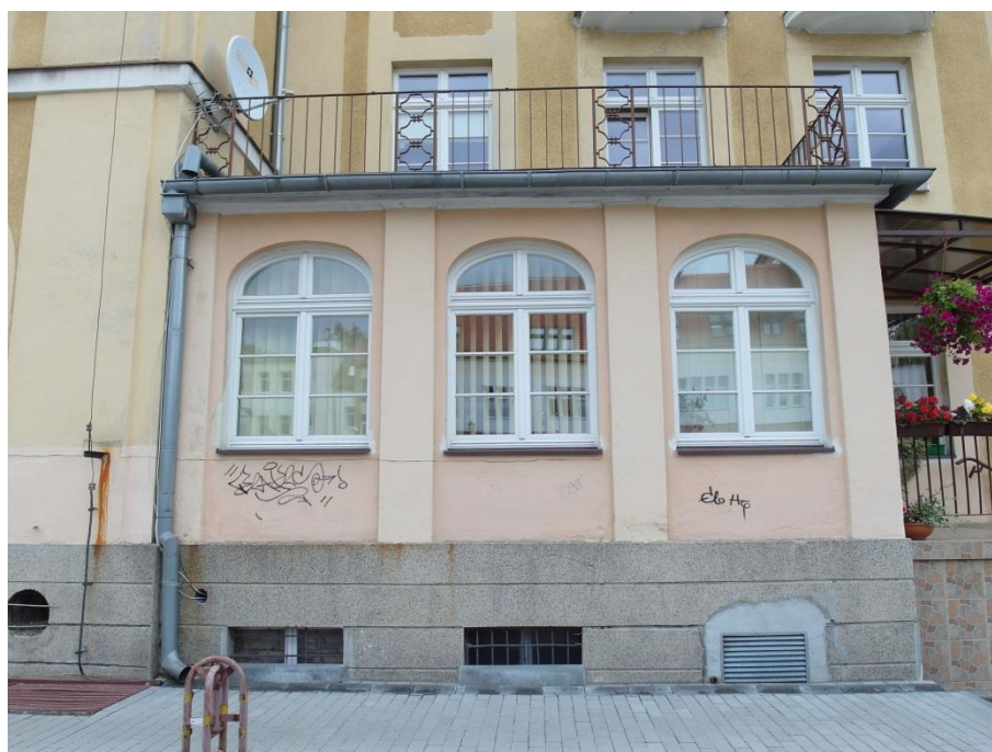
Sopot, ul. 1 Maja 12, Dom Studencki nr 8, elewacja zachodnia. Tynkowane lico pokryte zabrudzeniami i zanieczyszczeniami, miejscami silnie wypłukane; przybudówka portierni o zmienionej kolorystyce – efekt współczesnych napraw; lico szpecą napisy graffiti.
