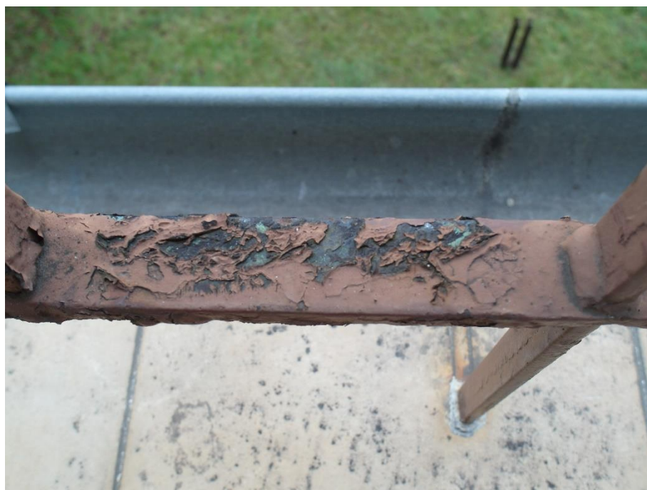
Sopot, ul. 1 Maja 12, Dom Studencki nr 8, elewacja zachodnia i południowa. Fragmenty metalowej balustrady tarasów, liczne wtórne warstwy przemalowań spękanе i złuszczone; widoczne ogniska korozji.
