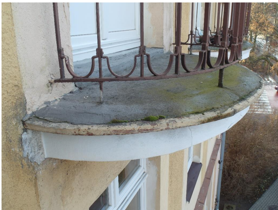
Sopot, ul. 1 Maja 12, Dom Studencki nr 8, elewacja zachodnia. Posadzka balkonów wykonana wtórnie materiałem na bazie cementu, obecnie utrzymująca zawilgocenie i pokryta mikroorganizmami.
