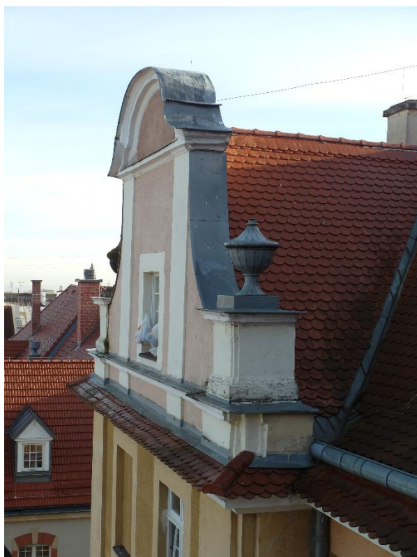
Sopot, ul. 1 Maja 12, Dom Studencki nr 8, elewacja północna. Tynkowane lico pokryte zabrudzeniami i zanieczyszczeniami, miejscami silnie wypłukane i odbarwione; widoczne uszkodzenia warstw tynkarskich i powłok malarskich spowodowane destrukcyjną działalnością wody opadowej.
