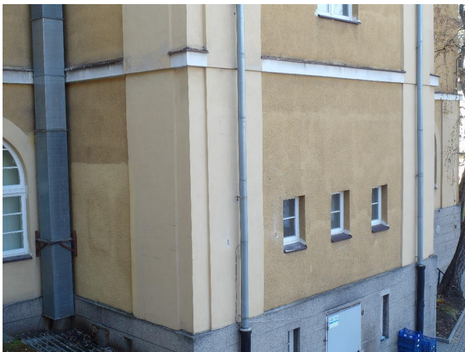
Sopot, ul. 1 Maja 12, Dom Studencki nr 8, elewacja wschodnia. Tynkowane lico elewacji pokryte zabrudzeniami i zanieczyszczeniami; wyraźnie widoczne granice nakładania farby oraz współczesne naprawy o charakterze interwencyjnym.
