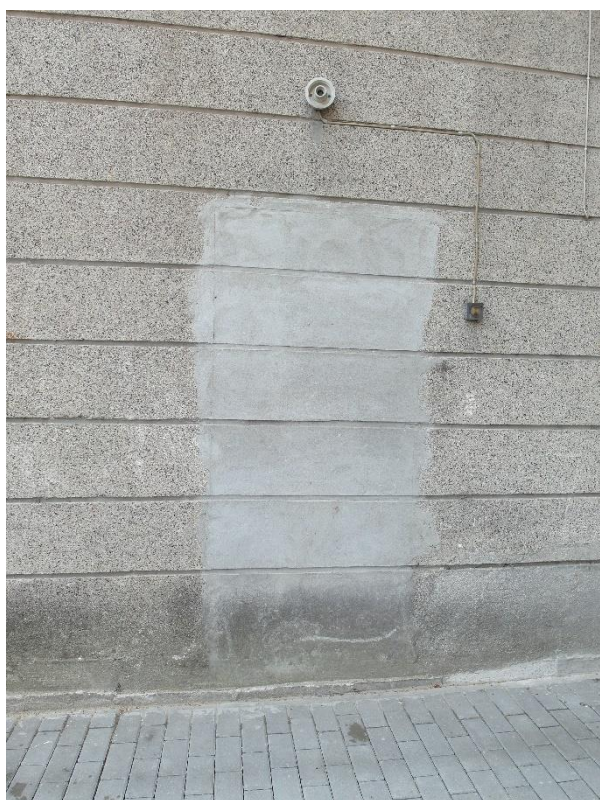
Sopot, ul. 1 Maja 12, Dom Studencki nr 8. Dolne partie elewacji pokryte cementowym tynkiem mozaikowym; lico zaśnieżone zanieczyszczeniami, zabrudzeniami, ponadto zawilgocone z bytującymi koloniami mikroorganizmów; widoczne wtórne uzupełniania i naprawy.
