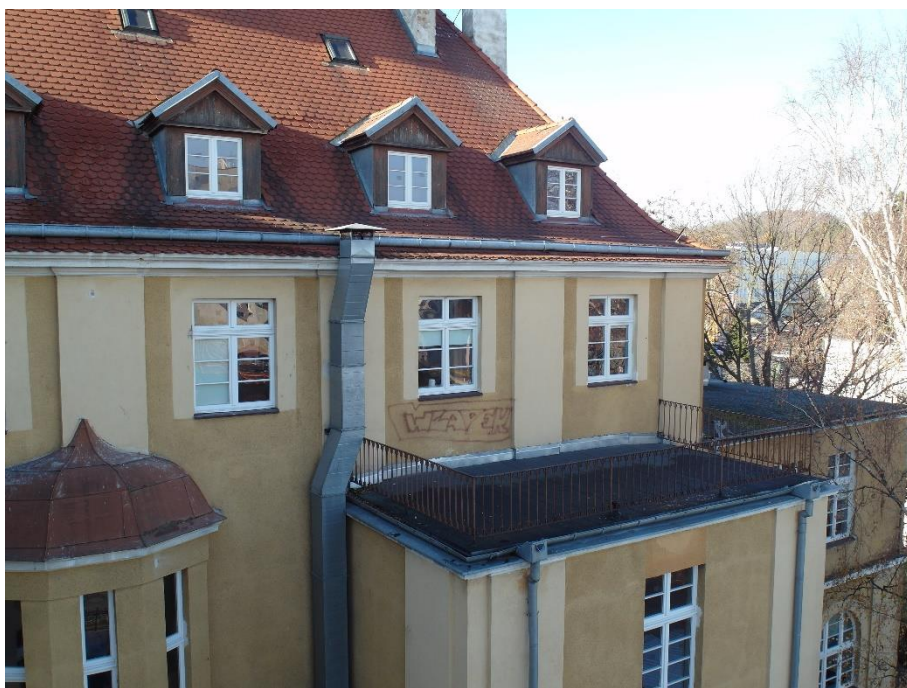
Sopot, ul. 1 Maja 12, Dom Studencki nr 8, elewacja wschodnia. Tynkowane lico zabrudzone i zanieczyszczone; ściana nad tarasem oszpecona napisami typu graffiti.
