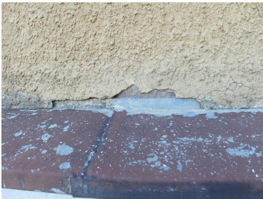
Sopot, ul. 1 Maja 12, Dom Studencki nr 8. Zbliżenie na tynkowane lico wyższych kondygnacji – pod ubytkami wtórnych wypraw tynkarskich i malarskich widoczne są oryginalne opracowania w postaci tynku barwionego w masie.
