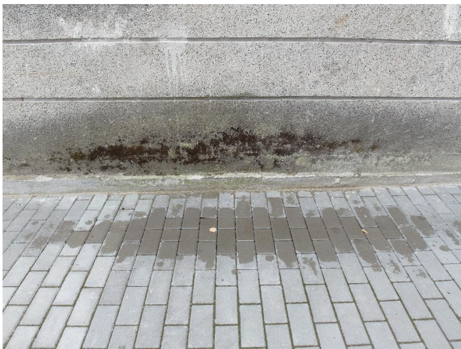
Sopot, ul. 1 Maja 12, Dom Studencki nr 8. Dolna partia elewacji pokryta cementowym tynkiem mozaikowym; z powodu odbijania się wody opadowej, wyprawy tynkarskie są silnie zawilgocone i pokryte mikroorganizmami.
