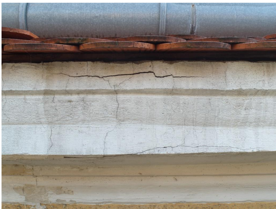
Sopot, ul. 1 Maja 12, Dom Studencki nr 8. Gzymsy koronujące elewacji zachodniej o zawilgoconej i spękanej strukturze; lico detalu pokrywają zabrudzenia i zanieczyszczenia; widoczne są ślady zacieków.
