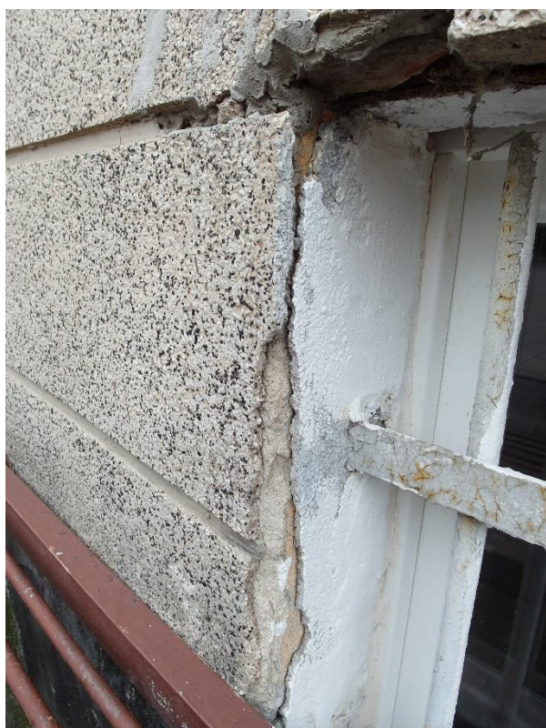
Sopot, ul. 1 Maja 12, Dom Studencki nr 8. Partia przyziemia; podczas wymiany stolarki okiennej usunięto wybrane kraty, pozostałe z widocznymi ogniskami korozji; część gładzi okiennych zdestruowana – tynki odspójone od podłoża, wtórnie i przemalowane.
