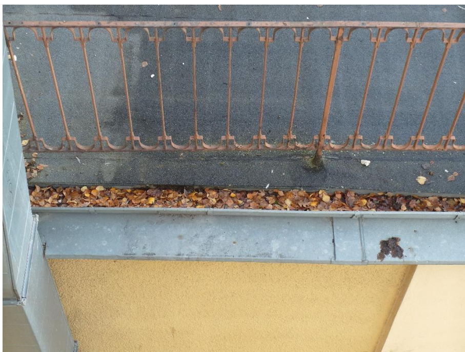
Sopot, ul. 1 Maja 12, Dom Studencki nr 8, elewacja zachodnia i wschodnia. Posadzki tarasów wyłożono warstwą papy termozgrzewalnej; w rynnach zalegają liście.
