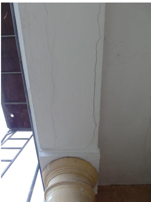
Sopot, ul. 1 Maja 12, Dom Studencki nr 8, elewacja południowa. Taras II kondygnacji, widoczne silne zabrudzenia tynkowanego lica; struktura belkowania spękana konstrukcyjnie.
