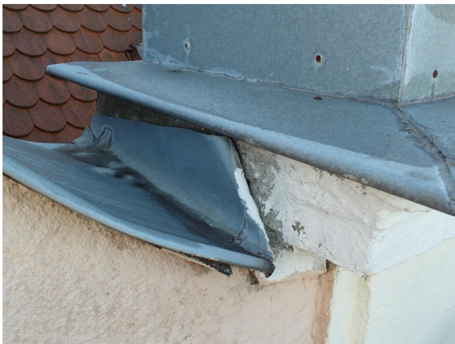
Sopot, ul. 1 Maja 12, Dom Studencki nr 8. Szczyt ryzalitu elewacji północnej. Nakrywa naczółka głęboko popękana w strukturze; poniżej widoczny sposób nałożenia obróbki blacharskiej.
