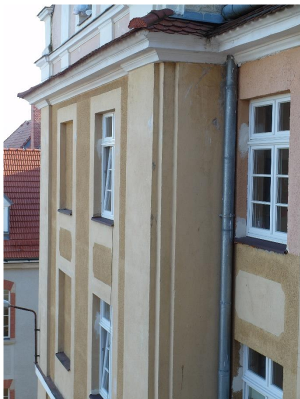
Sopot, ul. 1 Maja 12, Dom Studencki nr 8, elewacja północna. Tynkowane lico pokryte zabrudzeniami i zanieczyszczeniami, miejscami silnie wypłukane i odbarwione; widoczne uszkodzenia warstw tynkarskich i powłok malarskich spowodowane destrukcyjną działalnością wody opadowej.
