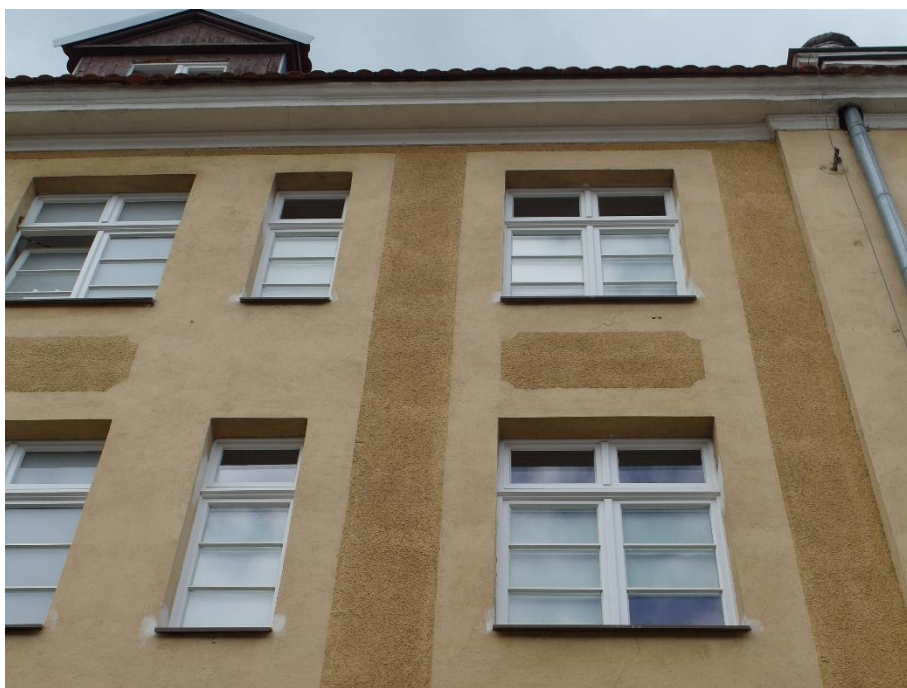
Sopot, ul. 1 Maja 12, Dom Studencki nr 8, elewacja wschodnia. Tynkowane lico części południowej pokryte zabrudzeniami i zanieczyszczeniami, szczególnie w partii dolnej kondygnacji; ponadto mozaikowy tynk parteru pokryty jest koloniami mikroorganizmów [grzyby].
