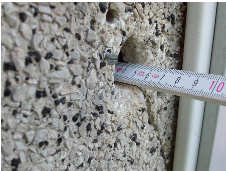
Sopot, ul. 1 Maja 12, Dom Studencki nr 8. Dolna partia lica pokryta cementowym tynkiem mozaikowym, zabrudzonym i spękanym; poniżej widoczna znaczna grubość wtórnej wyprawy.
