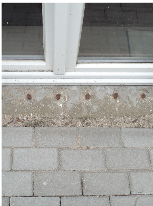
Sopot, ul. 1 Maja 12, Dom Studencki nr 8. Partia przyziemia; podczas wymiany stolarki okiennej usunięto wybrane kraty, pozostałe z widocznymi ogniskami korozji; część gładzi okiennych zdestruowana – tynki odspójone od podłoża, wtórnie i przemalowane.
