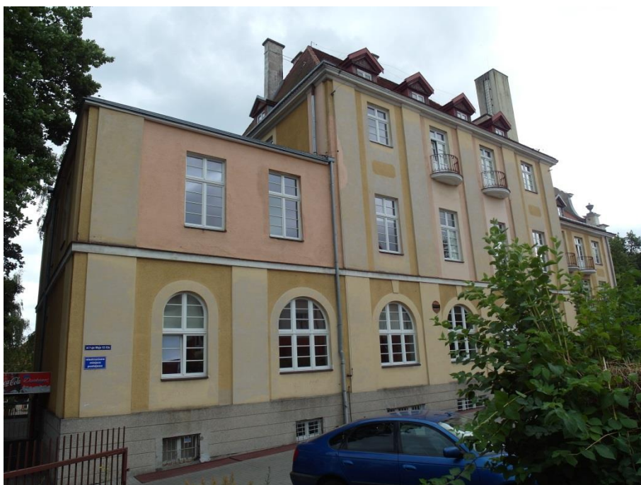
Sopot, ul. 1 Maja 12, Dom Studencki nr 8, elewacja zachodnia. Tynkowane lico elewacji pokryte zabrudzeniami i zanieczyszczeniami, miejscami wypłukane; widoczna zmienna kolorystyka w partiach III kondygnacji – efekt współczesnych napraw interwencyjnych.
