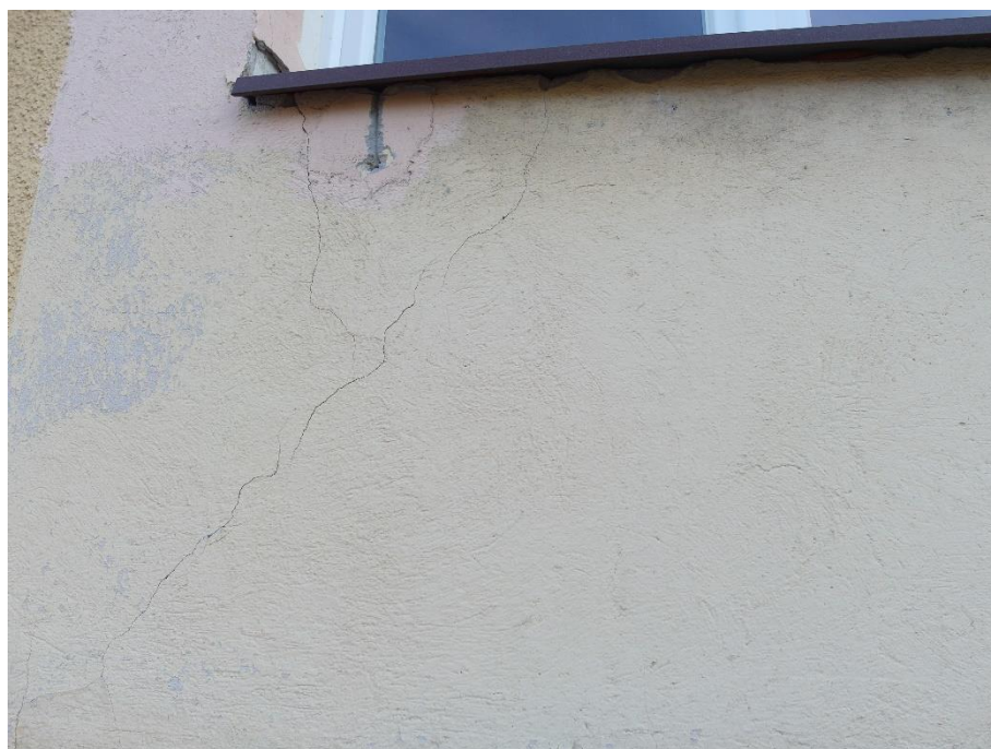
Sopot, ul. 1 Maja 12, Dom Studencki nr 8. Wtórne wyprawy tynkarskie wypłukane i spłowiałe z widoczną siatką spękań.
