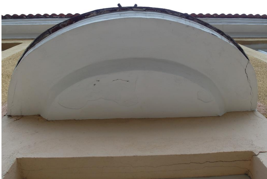
Sopot, ul. 1 Maja 12, Dom Studencki nr 8, elewacja zachodnia. Spód balkonów z widocznymi strukturalnymi spękaniami oraz zaciekami spowodowanymi przenikaniem przez warstwy posadzkowe wód opadowych.
