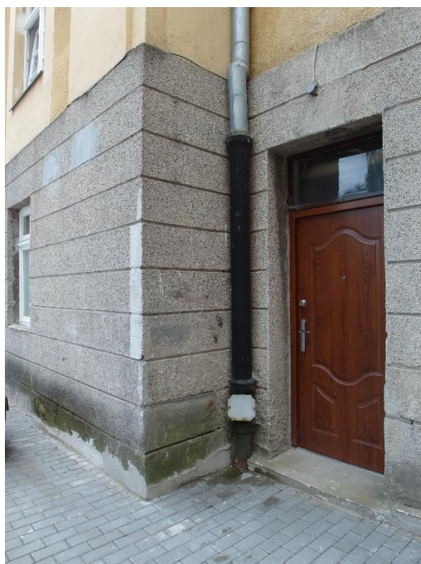
Sopot, ul. 1 Maja 12, Dom Studencki nr 8. Dolne partie elewacji pokryte cementowym tynkiem mozaikowym; lico zaśnieżone zanieczyszczeniami, zabrudzeniami, ponadto zawilgocone z bytującymi koloniami mikroorganizmów; widoczne wtórne uzupełniania i naprawy.
