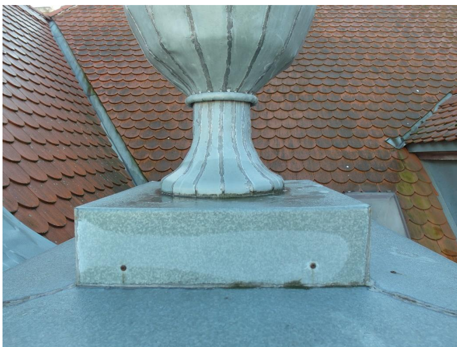
Sopot, ul. 1 Maja 12, Dom Studencki nr 8, elewacja północna, szczyt. Prawdopodobnie w wyniku prac remontowych oryginalne, zdestruowane wazony zostały zastąpione blaszanymi replikami.
