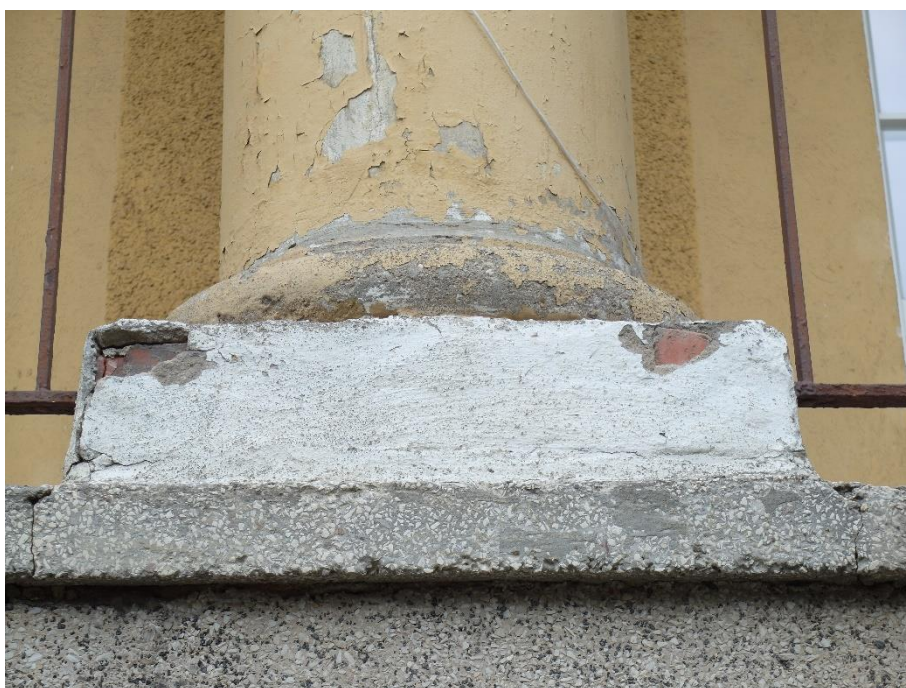
Sopot, ul. 1 Maja 12, Dom Studencki nr 8, elewacja południowa. Bazy kolumn obłożone cementowymi wyprawami tynkarskimi są spękane, odspojone z ubytkami; warstwy malarskie spękane i złuszczone.
