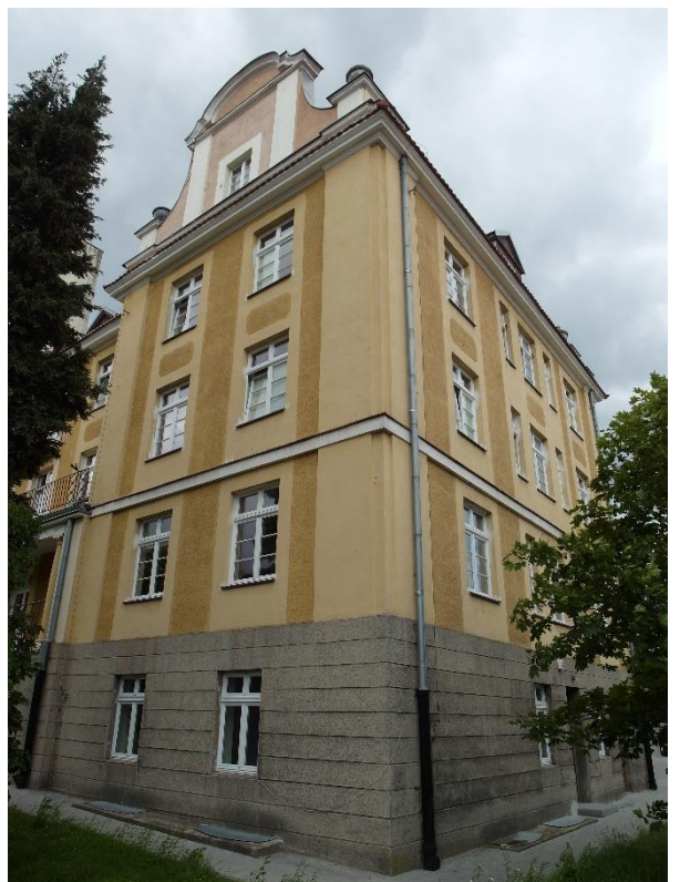
Sopot, ul. 1 Maja 12, Dom Studencki nr 8, elewacja południowa. Tynkowane lico elewacji pokryte zabrudzeniami i zanieczyszczeniami, miejscami silnie wypłukane; widoczne partie o zmienionej kolorystyce – efekt współczesnych napraw [szczyty, pilastry przy dolnym tarasie kolumnowym].
