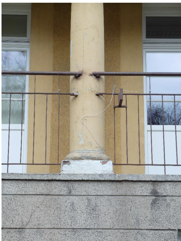
Sopot, ul. 1 Maja 12, Dom Studencki nr 8. Posadzki tarasów pokryte różnymi materiałami – papą termozgrzewalną i płytkami ceramicznymi; metalowe balustrady z licznymi warstwami przemalowań.
