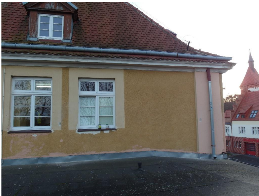
Sopot, ul. 1 Maja 12, Dom Studencki nr 8, elewacja północna. Kondygnacja IV, przy tarasie. Tynkowane lico pokryte zanieczyszczeniami; widoczne drobne ale, liczne współczesne naprawy w partiach pod oknami i na pilastrach.
