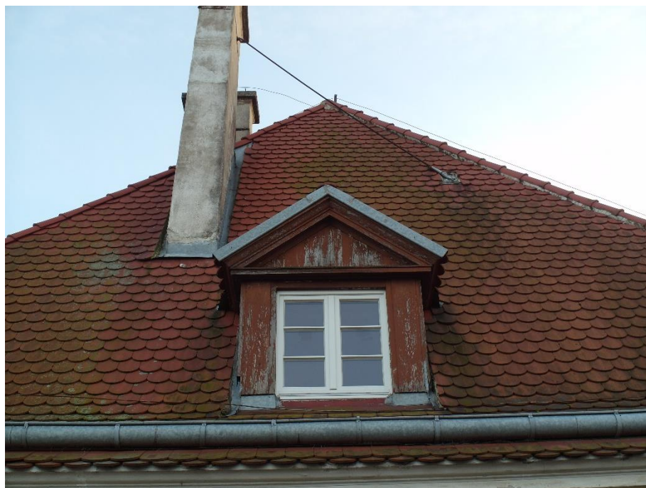
Sopot, ul. 1 Maja 12, Dom Studencki nr 8. Połacie dachu przykryte dachówką typu karpiówka, obecnie silnie zabrudzoną i pokrytą koloniami mikroorganizmów.
